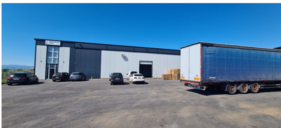
Slika 2.5. Izgled objekta u kojem se planira projekat
