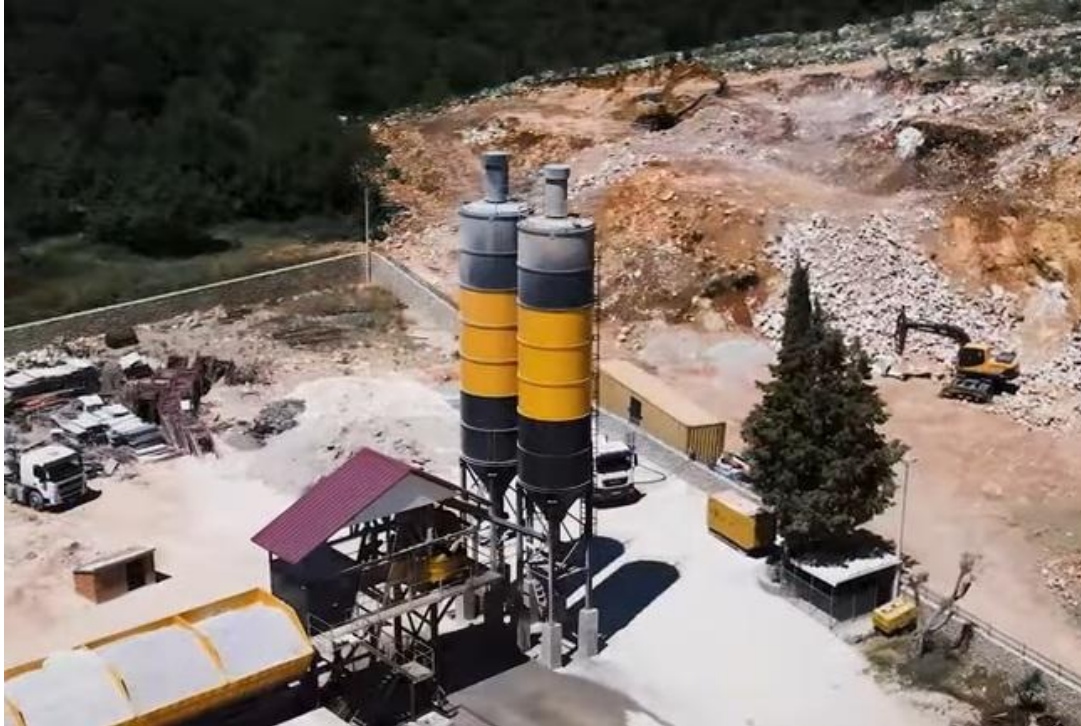
Slika 15. Silosi za skladištenje cementa
