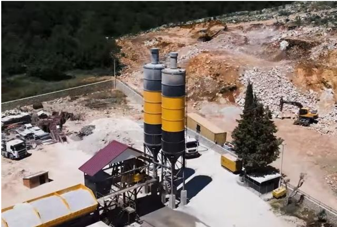
Slika 19. Silosi za skladištenje cementa
