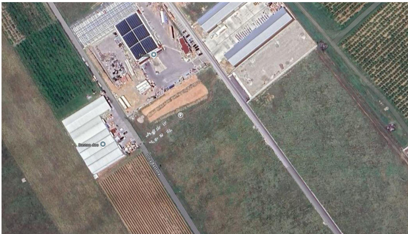
Slika 2. Lokacija objekta sa užom okolinom
