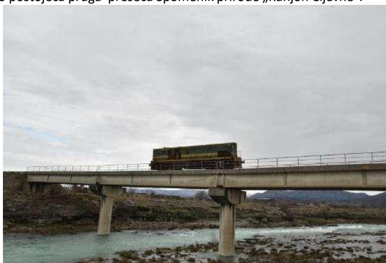
Slika 9 Željeznički most preko rijeke Cijevne (42.397073° N, 19.300175° E)
